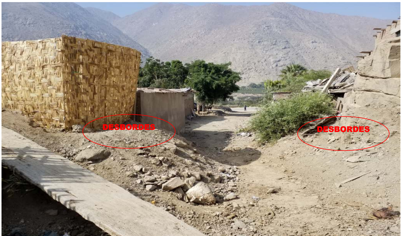
FIGURA N°02: MATERIAL COLMATADO EN EL CAUCE DE LA QUEBRADA SAN MIGUEL, CON UNA PROFUNDIDAD PROMEDIO DE 1.0 M. ESTO PROVOCA QUE DESBORDAMIENTO DEL RÍO SEA MAS INMINENTE.
