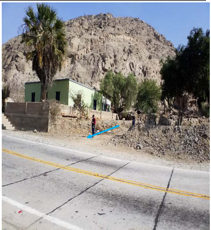
FIGURA N°03: EN LA TEMPORADA DE MAXIMAS AVENIDAS LA QUEBRADA SAN MIGUEL SE DESBORDA, POR LA MARGEN DECHECHA E IZQUIERDA, EN EL SECTOR SAN MIGUEL, DISTRITO DE HUARAL, CUYO TRAMO SE ENCUENTRA COLMATADO Y DESPROTEGIDO, VULNERABLE A LAS VELOCIDADES EROSIVAS DEL RÍO.
