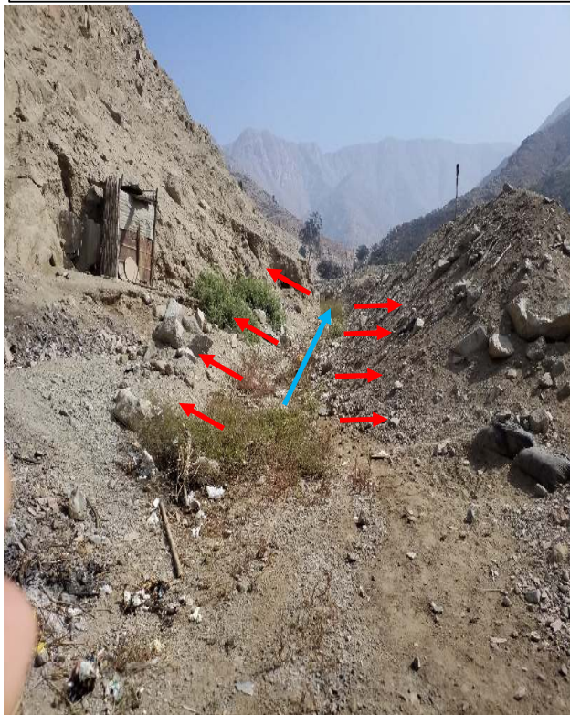
FIGURA N°03: EN LA TEMPORADA DE MAXIMAS AVENIDAS LA QUEBRADA SAN MIGUEL SE DESBORDA, POR LA MARGEN DECHECHA E IZQUIERDA, EN EL SECTOR SAN MIGUEL, DISTRITO DE HUARAL, CUYO TRAMO SE ENCUENTRA COLMATADO Y DESPROTEGIDO, VULNERABLE A LAS VELOCIDADES EROSIVAS DEL RÍO.
